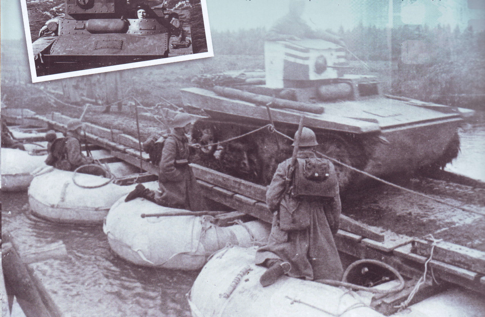
★ Танк Т-37А преодолевает водную преграду по наплавному мосту. Ленинградский военный округ. 1936 год.
